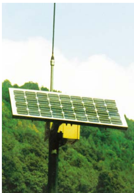
Fig. 2.20 Pannello fotovoltaico di alimentazione della rete radiotelefonica di emergenza lungo una strada alpina.
